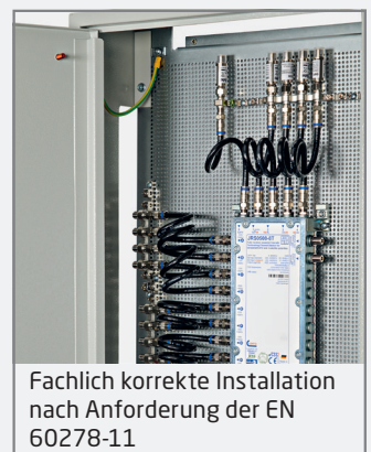
Auf Lochblech-Montageplatte vormontiert, im Stahlblech-Montagegehäuse
